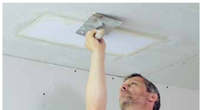
Übergänge und Schraubenlöcher spachteln ohne die Membran komplett zu überspachteln.
