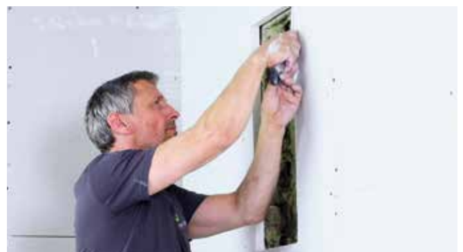
Kanten der Einbauöffnung anschrägen.
