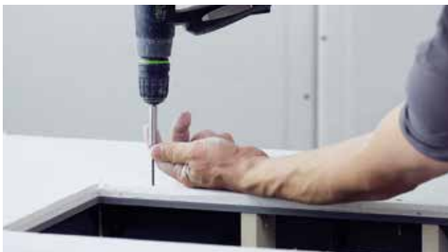
Gehäuse ringsum mit der GK-Platte verschrauben.
