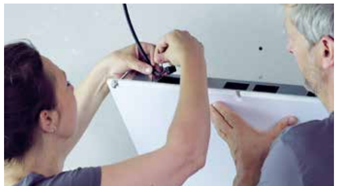
Lautsprecherkabel anschließen und zugentlasten. Dann den Lautsprecher einsetzen und mit den ersten zwei Schrauben fixieren.
