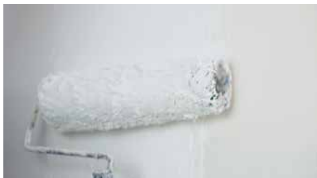
Farbe auftragen. ACHTUNG! Der Spachtel muss vorher vollständig durchgetrocknet sein!
