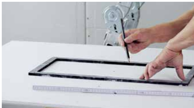
Einbauposition festlegen und Ausschnitt anzeichnen. Rahmen als Schablone verwenden (Montageöffnung)
