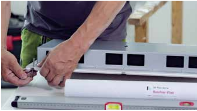
Zwei Befestigungsschrauben diagonal einstecken und mit O-Ringen sichern.
