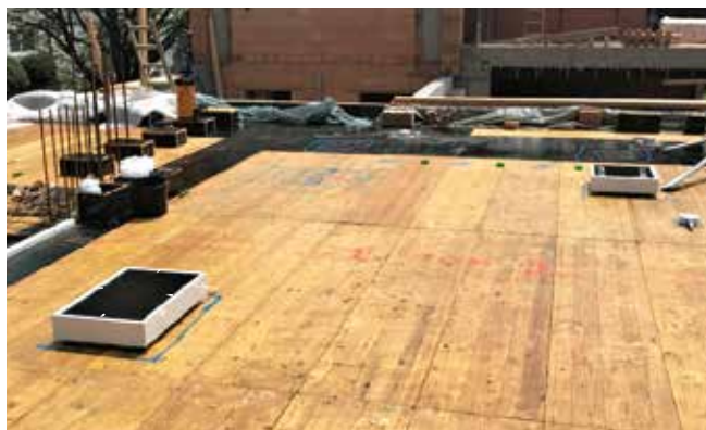
Positionierung der Einbaugehäuse auf der Schalung
