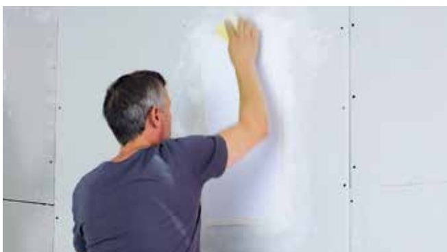
Überstehenden Spachtel wegschleifen. ACHTUNG! Die Grundierung auf der Membrane darf nicht durchgeschliffen werden!
