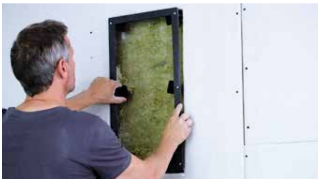
Montagefüße mit Rahmen einsetzen...
