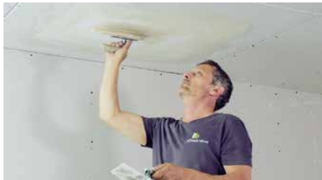
Membrane und Umgebung flächig dünn spachteln.
