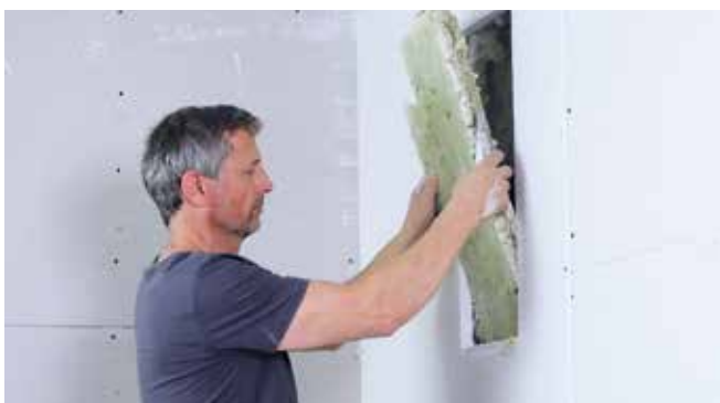
Dämmwolle entfernen bis der Einbauraum für den Lautsprecher freiliegt.
