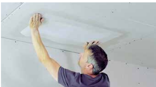
Dann in den feuchten Spachtel das Glasfaservlies einlegen und glattstreichen. Trocknen lassen und danach schleifen.
