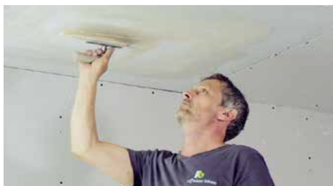
Glasfaservlies und Umgebung flächig spachteln bis ein völlig glatte Fläche entsteht.
