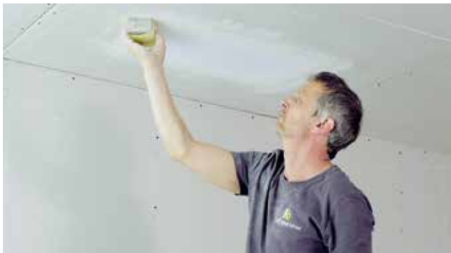
Überstehenden Spachtel wegschleifen. ACHTUNG! Die Grundierung auf der Membrane darf nicht durchgeschliffen werden!
