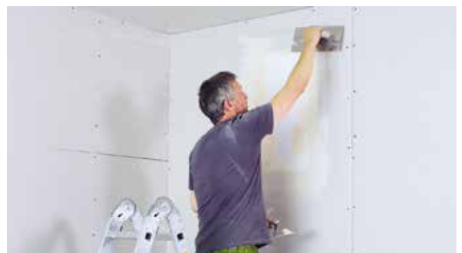
Membrane und Umgebung flächig dünn spachteln.
