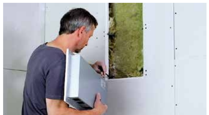
Lautsprecher anschließen. Kabel mit Kabelbinder zugentlasten.
