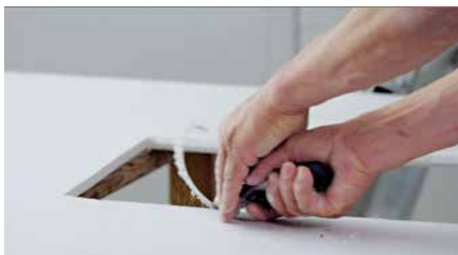
Kanten der Einbauöffnung anschrägen...
