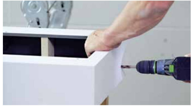
Gehäuse mit Bohrung für Zuleitung versehen.
