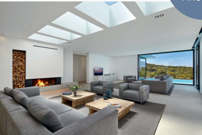
Privatvilla Mallorca, unsichtbare Multi-Room Beschallungsanlage
